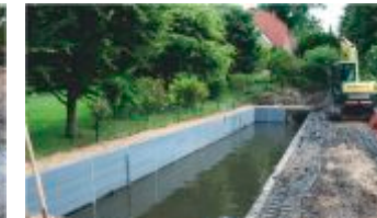
Erd- und Tiefbau
