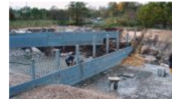
Erd- und Tiefbau
